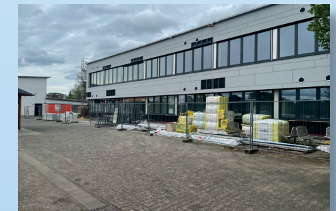
Gutenberg Grundschule, Dierdorf Die Verbandsgemeinde investiert ca. 5 Millionen Euro
