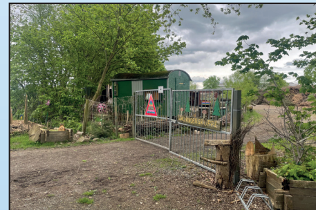
Waldkindergarten Wir werden den Wassereintritt im Dach beseitigen
