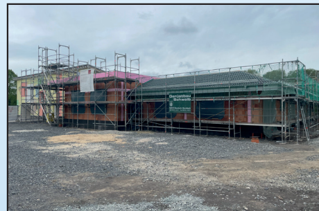
Kita Holzbachfrösche Neubau von Gruppen
